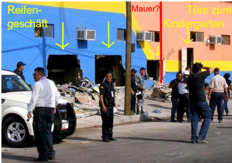
Bild 2: Die ersten drei Pfeile von links bezeichnen das (wahrscheinliche) Reifengeschäft. Die drei Öffnungen und der darunterliegende Schaden weisen viel mehr auf eine Explosion hin, als auf einen Brand (keine schwarzen oder verkohlten Stellen)
