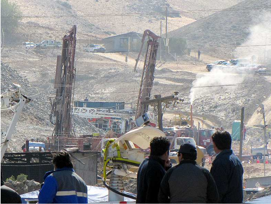
(Großbohrgeräten in der Kupfer- und Goldmine San Jose, Chile)
