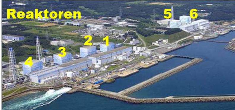
(Japan: Atomkraftwerk Fukushima vor dem 11. 3. 2011)
