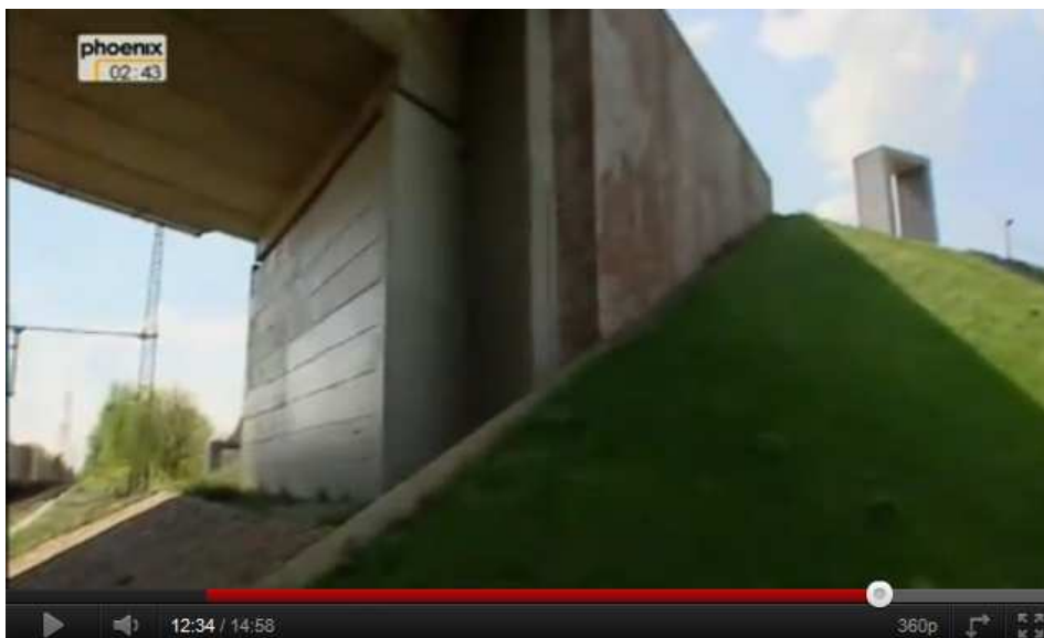
(Eschede, Rebberlaher Straße, Brückenrampe West. Das Gebilde oben rechts wird noch besprochen.)
