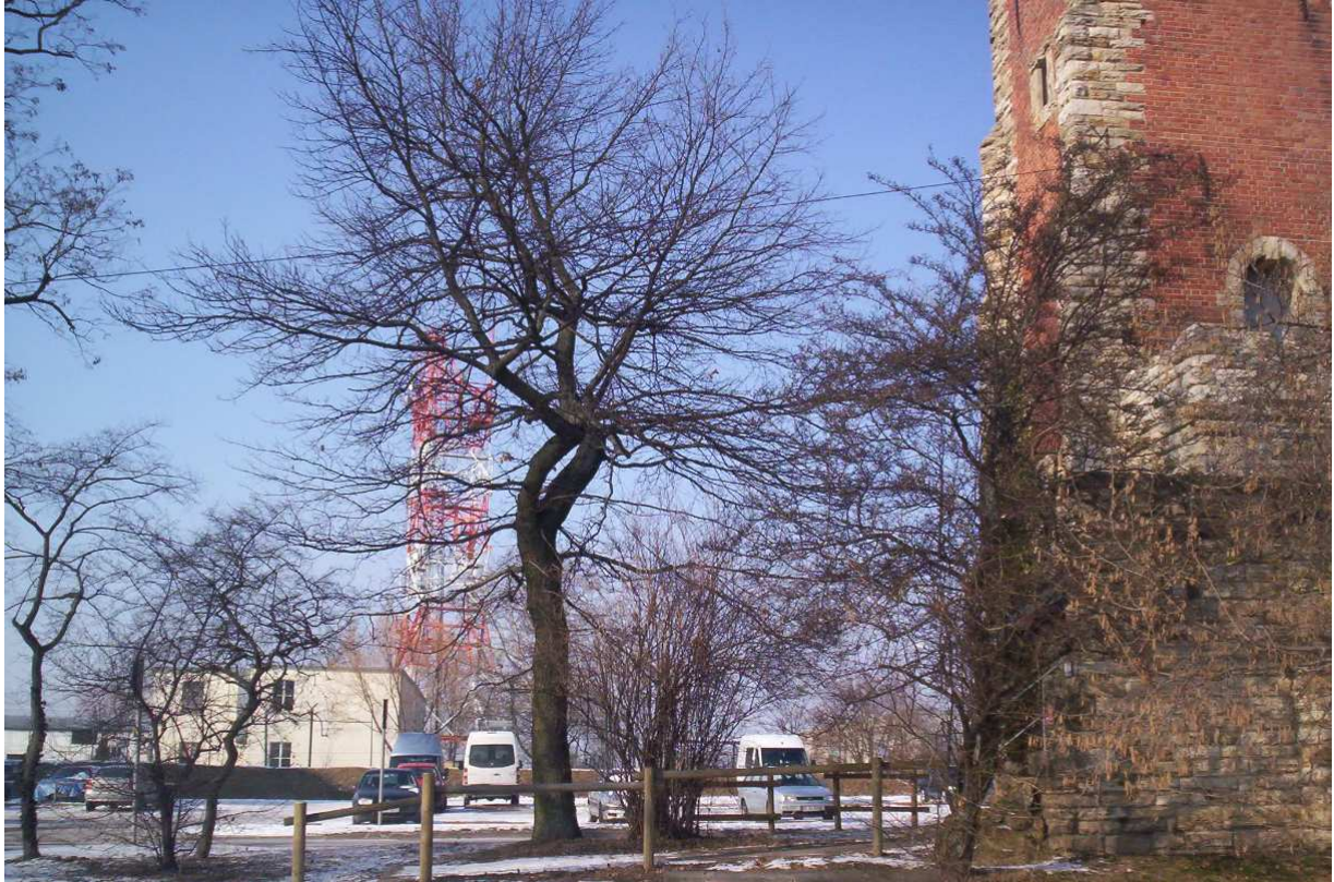
(Der amerikanische Funkturm steht auf dem höchsten Punkt der Gegend in der US-Kaserne Robinson Barracks . Rechts ist der Aussichtsturm von Burgholtzhof zu sehen.)
