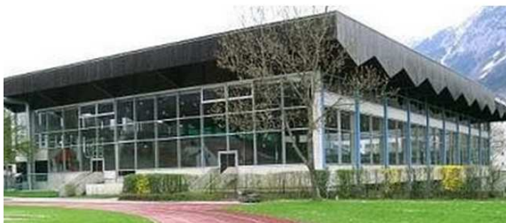
Die Reichenhaller Eishalle.
